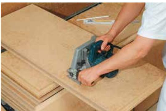
**Perfekte Verarbeitung leicht gemacht - Die Holzweichfaserplatte lässt sich mit der Tisch- oder Handkreissäge einfach und maßgenau zuschneiden.**
