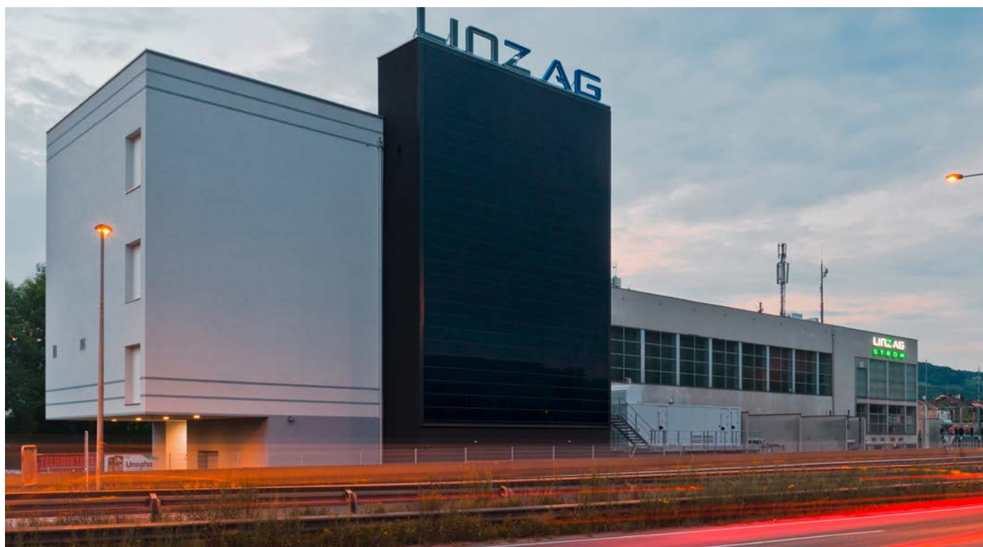
Data Center 2 Linz AG, AT (Projektant: BHM-Ingenieure, Linz, AT; Fasadni sustav: StoVentec Photovoltaics Inlay, StoTherm sustav; fotografija: Christian Schellander, artboxx)
