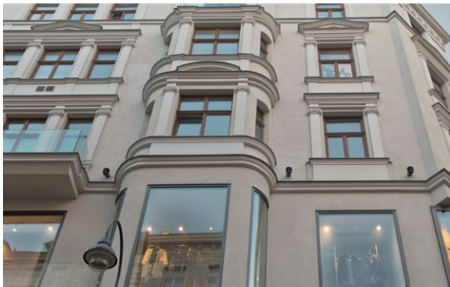
Slika lijevo/dolje: Poslovna kuća Kärntnerstraße, Beč, AT Arhitekt: BWM Architekten, Beč, AT Proizvodi: StoDeco fasadni profili Fotografija: Christian Schellander, AT
