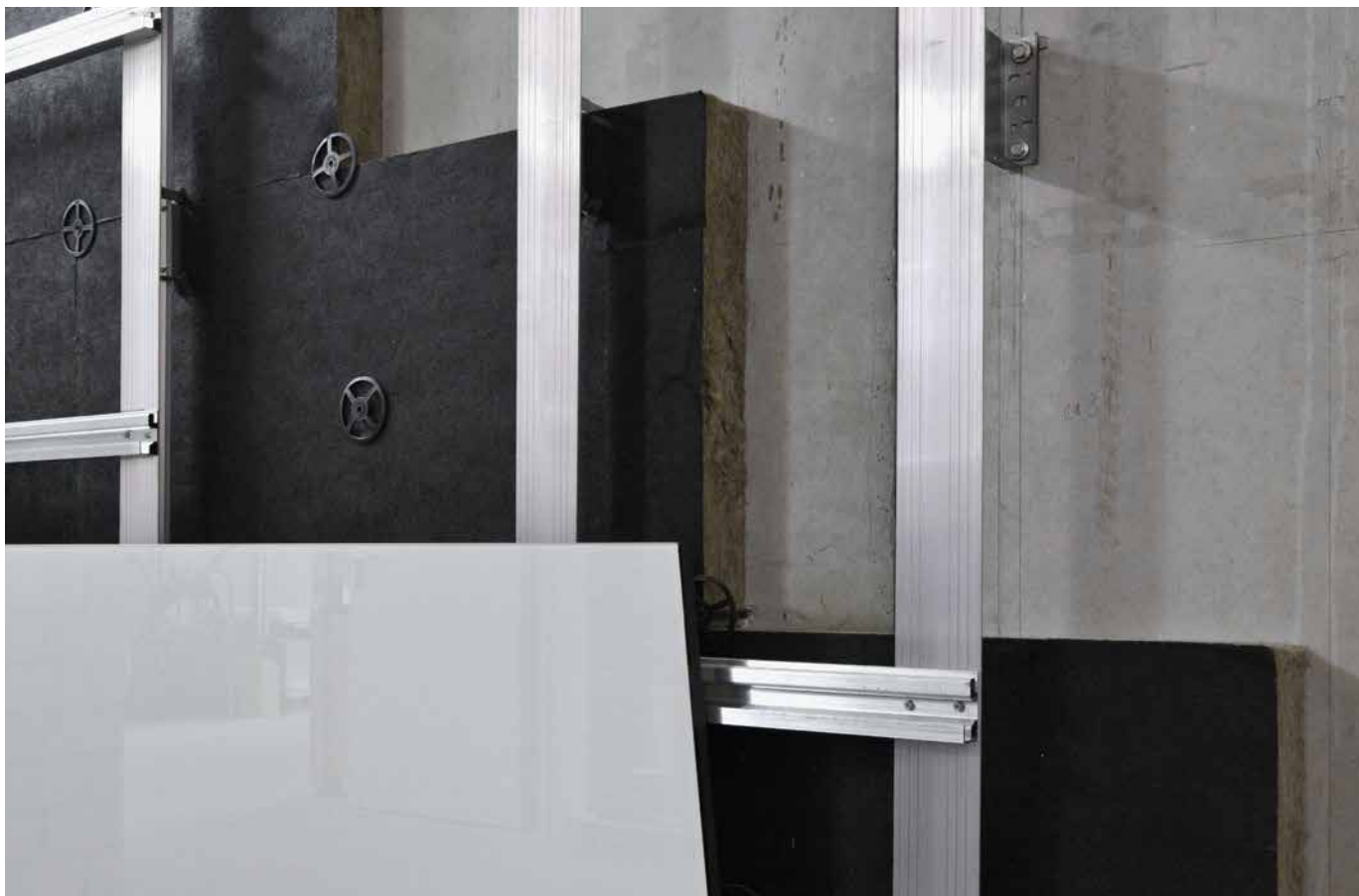
Struktura sustava StoVentec s podkonstrukcijom od oplemenjenog čelika i aluminija
