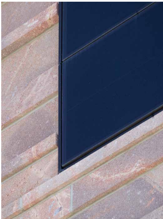
Detalj na prijelazu nevidljivo pričvršćenih fotonaponskih ploča na fasadu od prirodnog kamena
