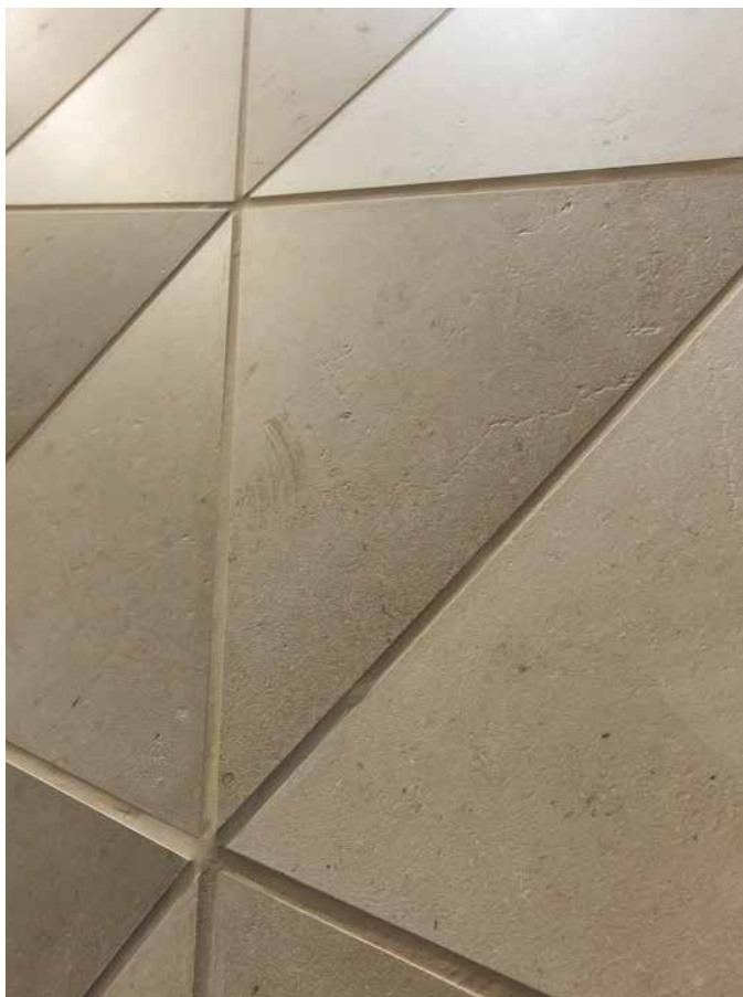
Detalj pločica od prirodnog kamena kao optimalno izrezana obloga slobodna oblika, nijansirani mort za spojnice kao dodatno sredstvo oblikovanja
