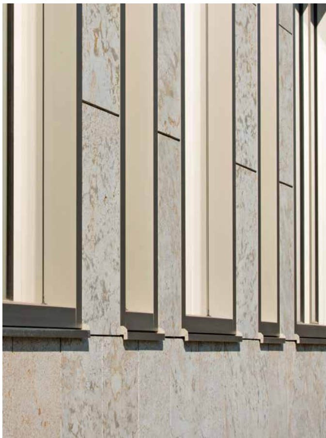
Izrada prozora na fasadi od prirodnog kamena naglašenoj spojnica
