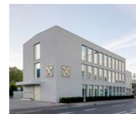
Raiffeisenbank Vorderland, Sulz, AT
