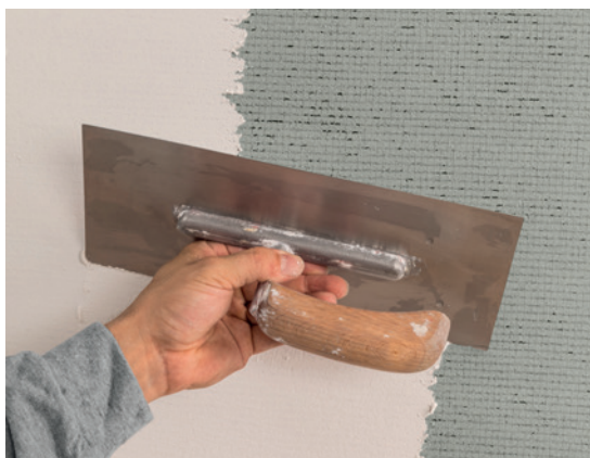
Nanošenje završnog premaza
