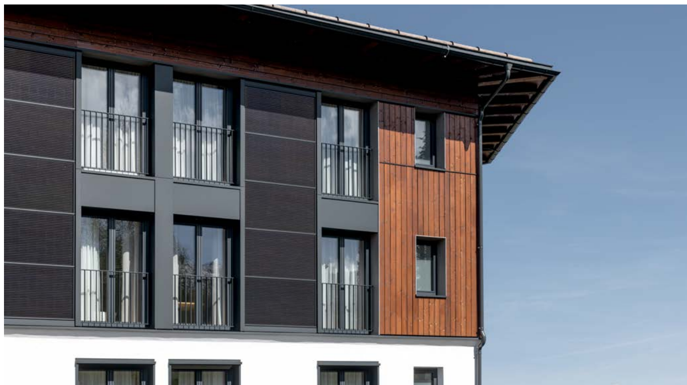
Mješovita fasada sa StoVentec Photovoltaics Inlay
