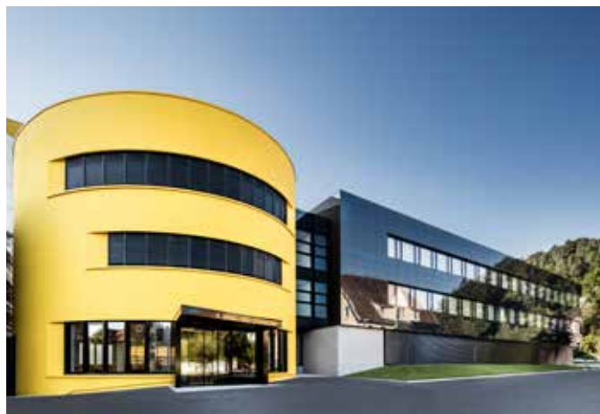
Prijemna zgrada Centrale poduzeća Sto, Weizen, DE Kod naše prijemne zgrade su korištene četiri različite površine: staklo, fotonaponski modul, žbuka i plastični fasadni elementi od Verolitha. Radi se o zgradi nulte energije s certifikatom Platin društva DGNB. Fotografija: Martin Baitinger, Böblingen, DE
