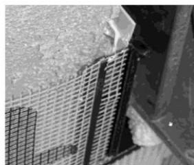
Eingebautes Eckstück mit Fugenflankenprofil-Verbinder
