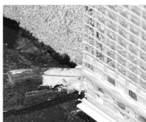
Justieren des Fugenflankenprofil- Verbinders
