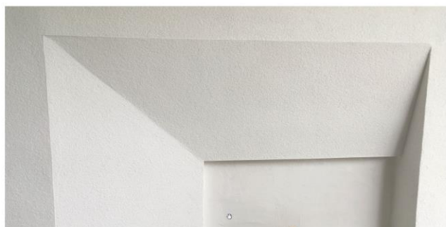
Sto-Kantenprofil Y-Flex – crteži i primjer primjene
