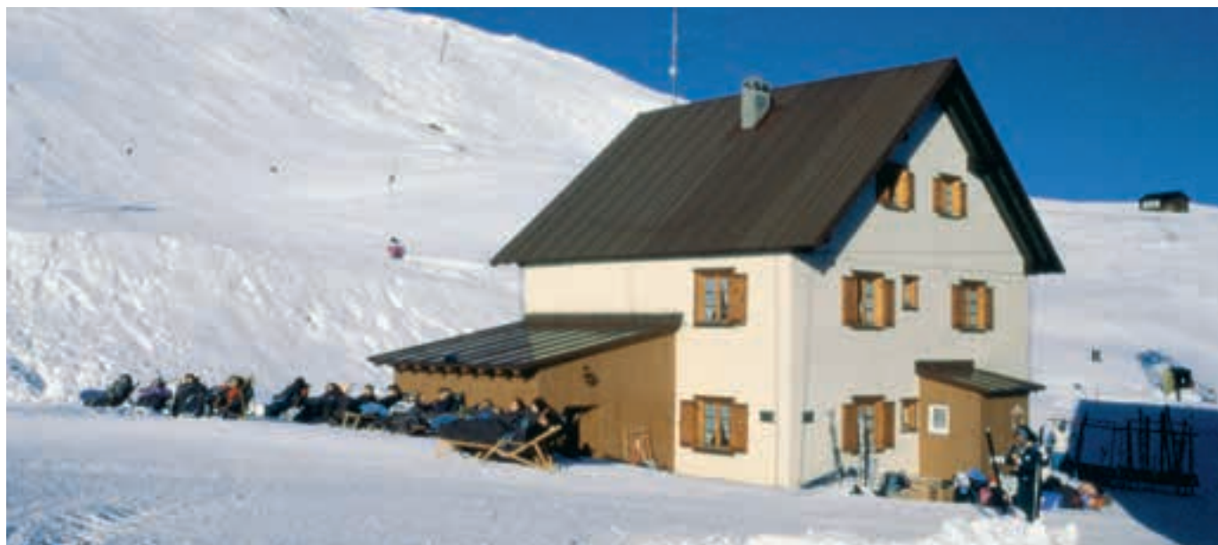
Das erste, noch als Testobjekt geführte Gebäude mit Sto-WDVS steht in alpiner Umgebung und bringt wertvolle Erkenntnisse zu Langzeitverhalten und Effektivität.
